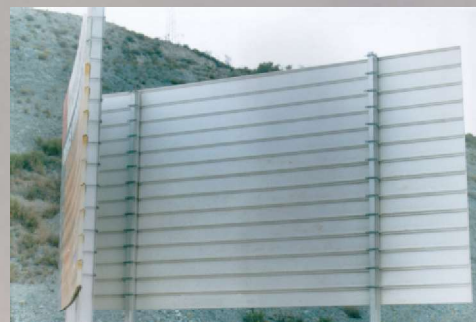
Forma de colocación Colocar la primera lama inferior a nivel Y el resto a continuación hacia arriba
