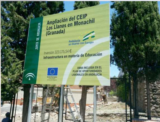
Cartel de obras en lama de PVC
