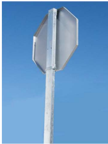
Sistema de agarre convencional con escuadras a poste rectangular
