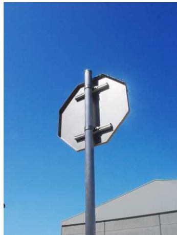
Sistema de agarre mediante perfil corredera y abrazadera a poste circular
